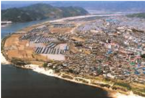
남지 제방축조 (전) / 사진 : 하동철
