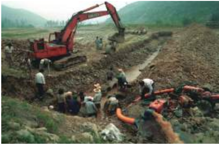
가뭄(하천물길작업) / 사진 : 하동철
