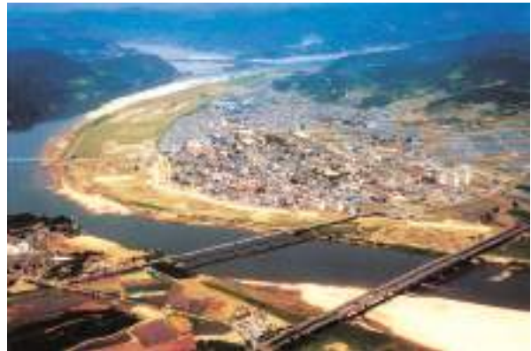
남지 제방축조 (후) / 사진 : 하동철
